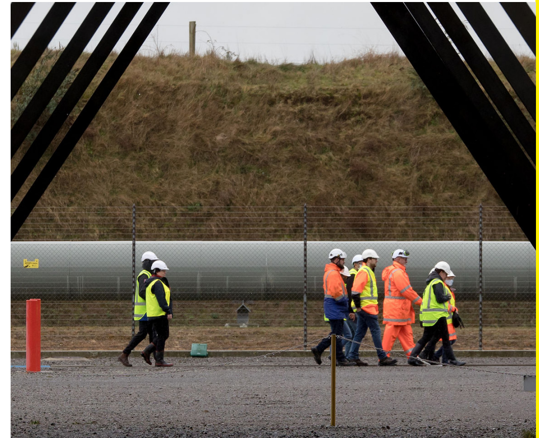
Nga Tamariki geothermal station.
