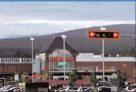
Carrefour St. David Avenue St. David Ouest & rue Clemenceau, Québec City
