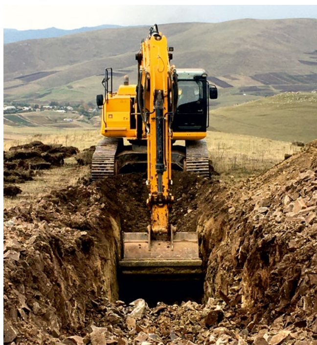
Trenching at Avshancli.
