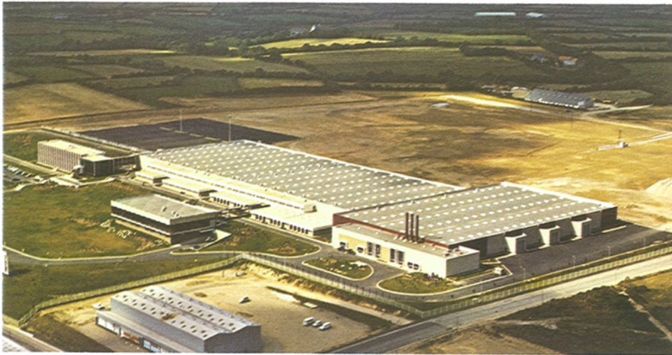
Société Française des Téléphones Ericsson produces subscriber equipment in this new plant at Brest.
