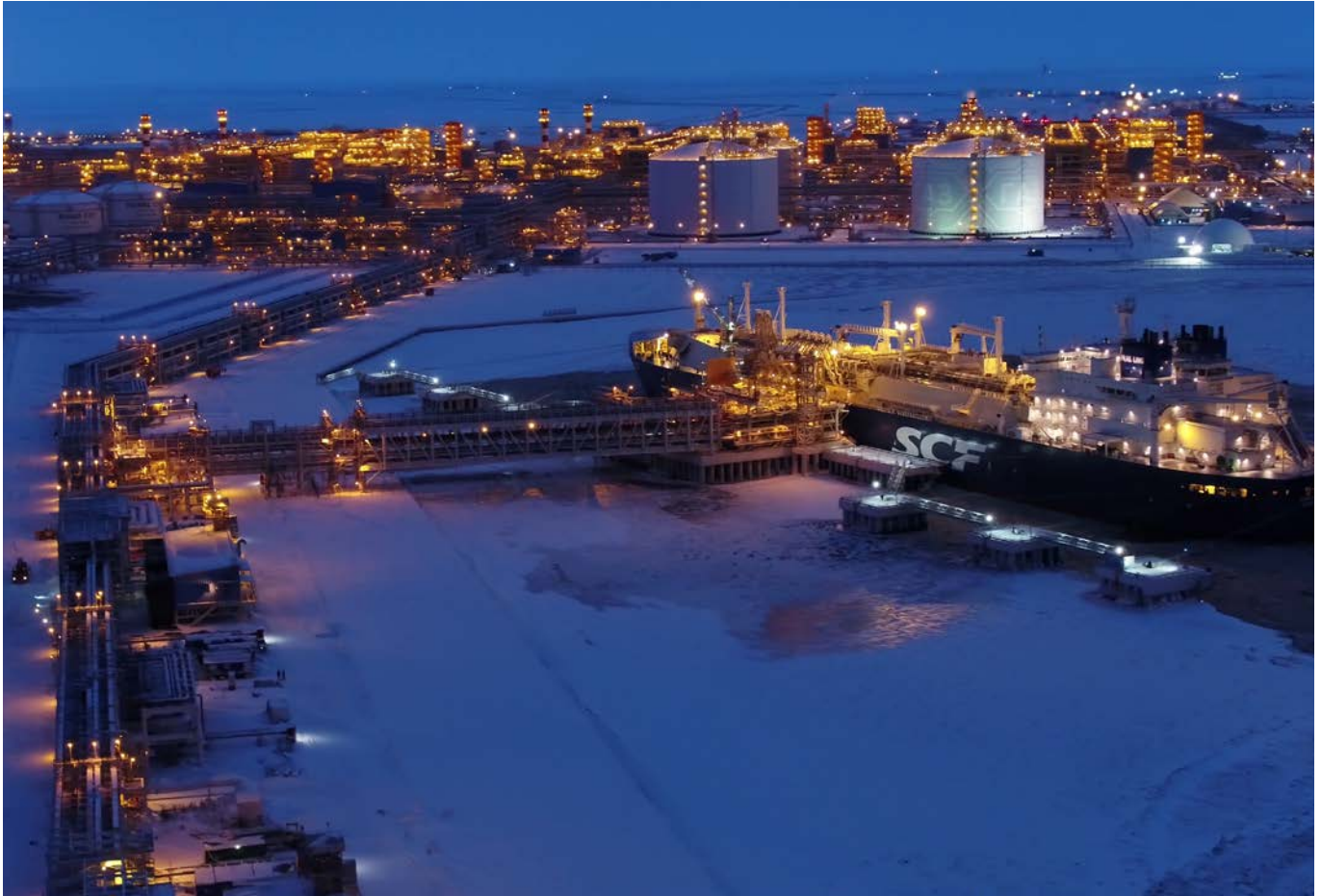
Yamal LNG project. Loading of LNG tanker
