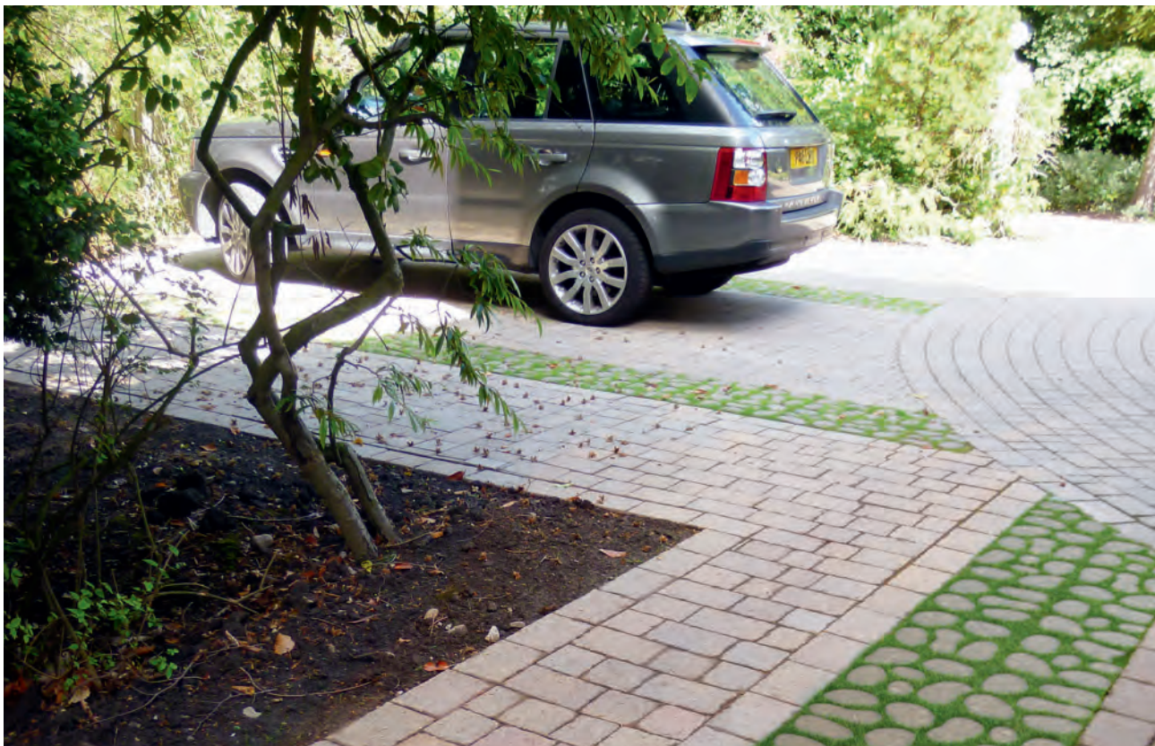
Biodiverse Permeable Paving
