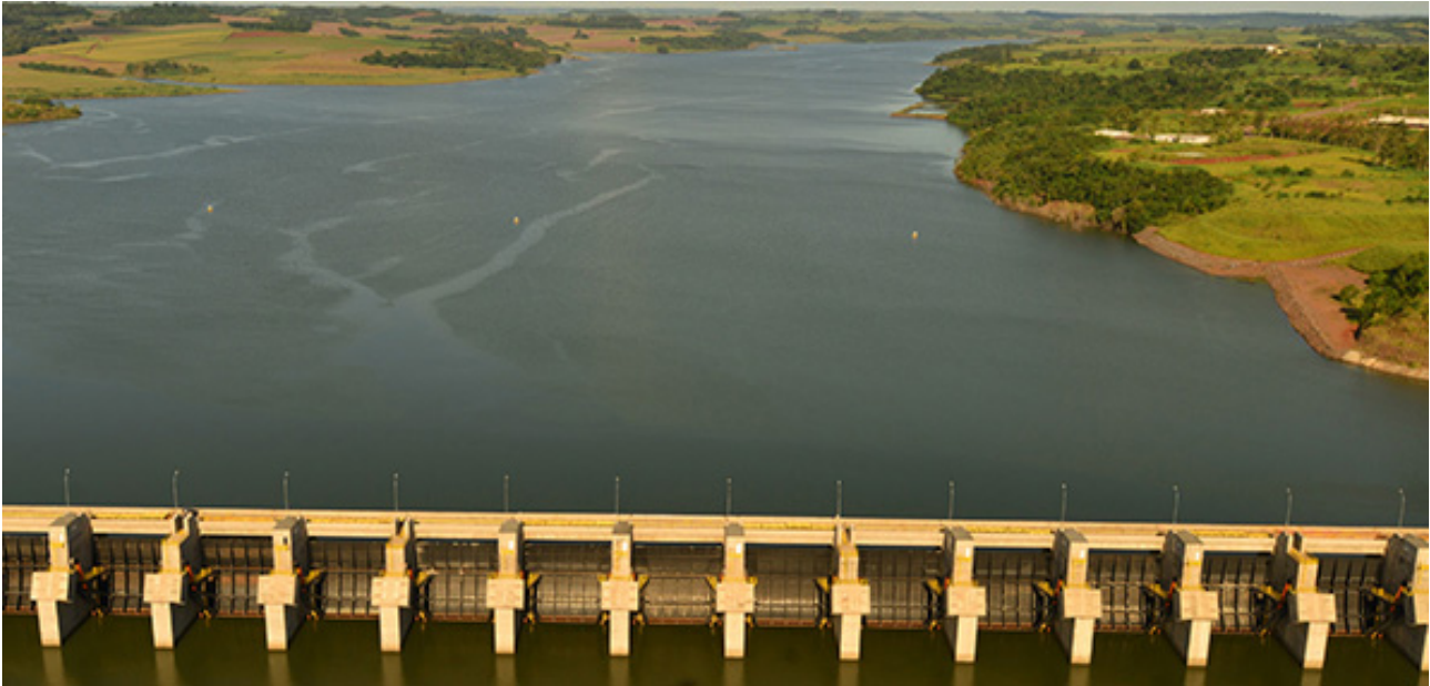
The Baixo Iguazú hydroelectric plant - Paraná, Brazil
