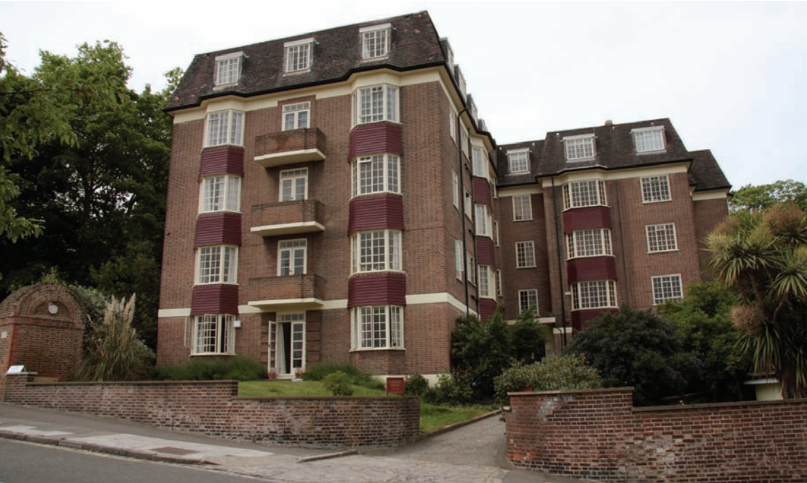
Left: Conduit House Greenwich London SE10
