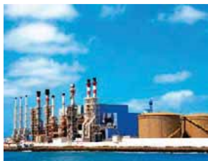
Thermal desalination plant.
