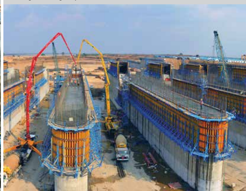
Medigadda Barrage Project
