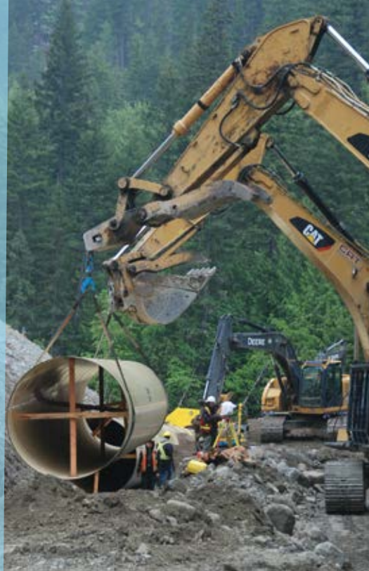
Installation d'une conduite forcée au projet hydroélectrique Kwoiek Creek, en Colombie-Britannique.
