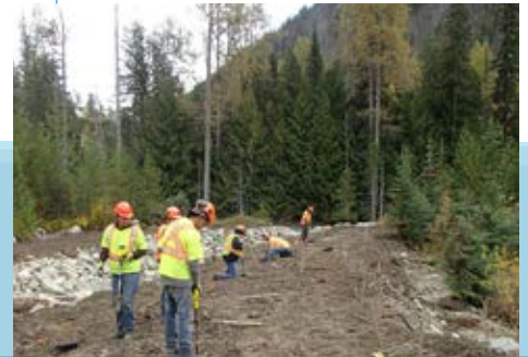
Mise en place d'un habitat compensatoire pour les poissons au projet hydroélectrique Kwoiek Creek, en Colombie-Britannique.
