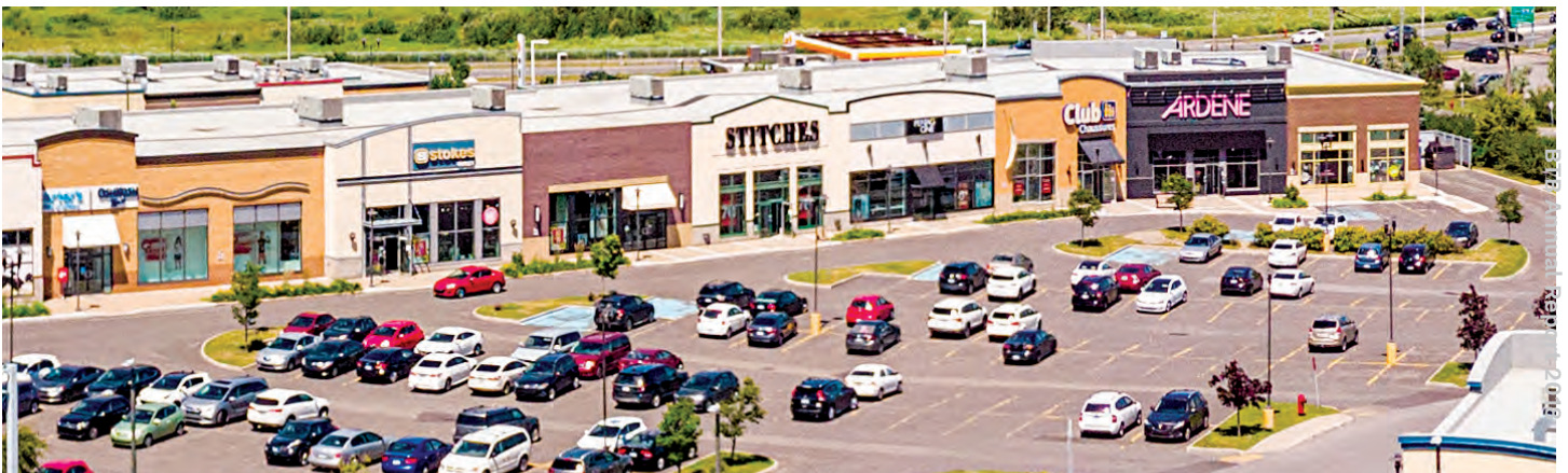
625-675, De la Concorde Street, Lévis
