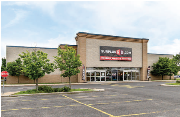
800 de l'Étang Street, Saint-Bruno-de-Montarville
