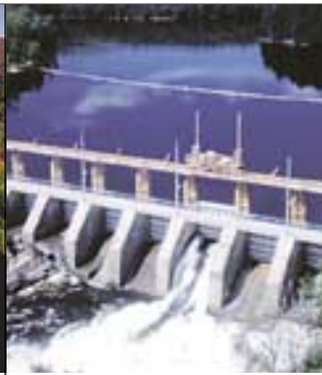
Rapide-des-Cèdres Dam Lièvre River, Quebec
