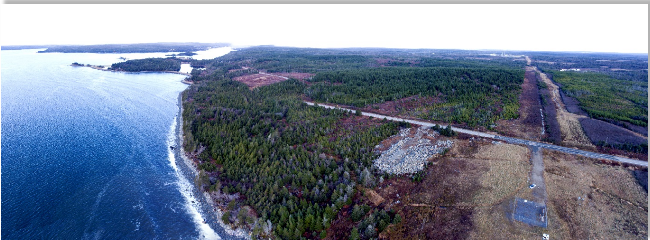
Cleared Goldboro LNG site in Nova Scotia
