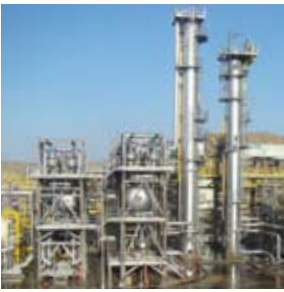
Planta de Fraccionamiento de Gas de GMP Pariñas – Talara
