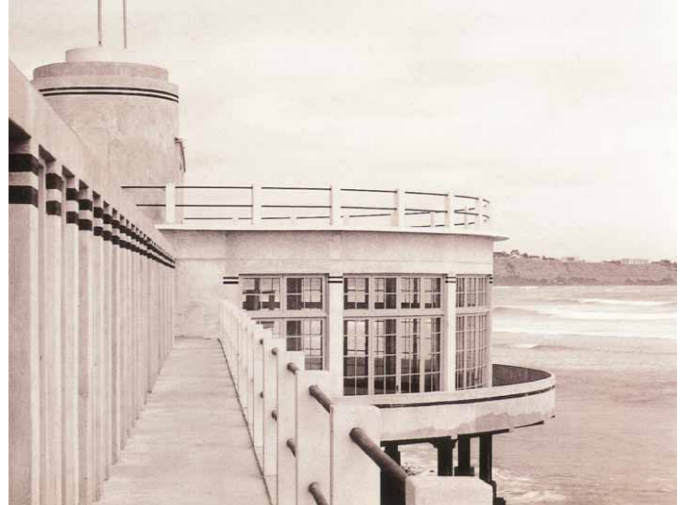
1937 - BAÑOS MUNICIPALES DE MIRAFLORES
