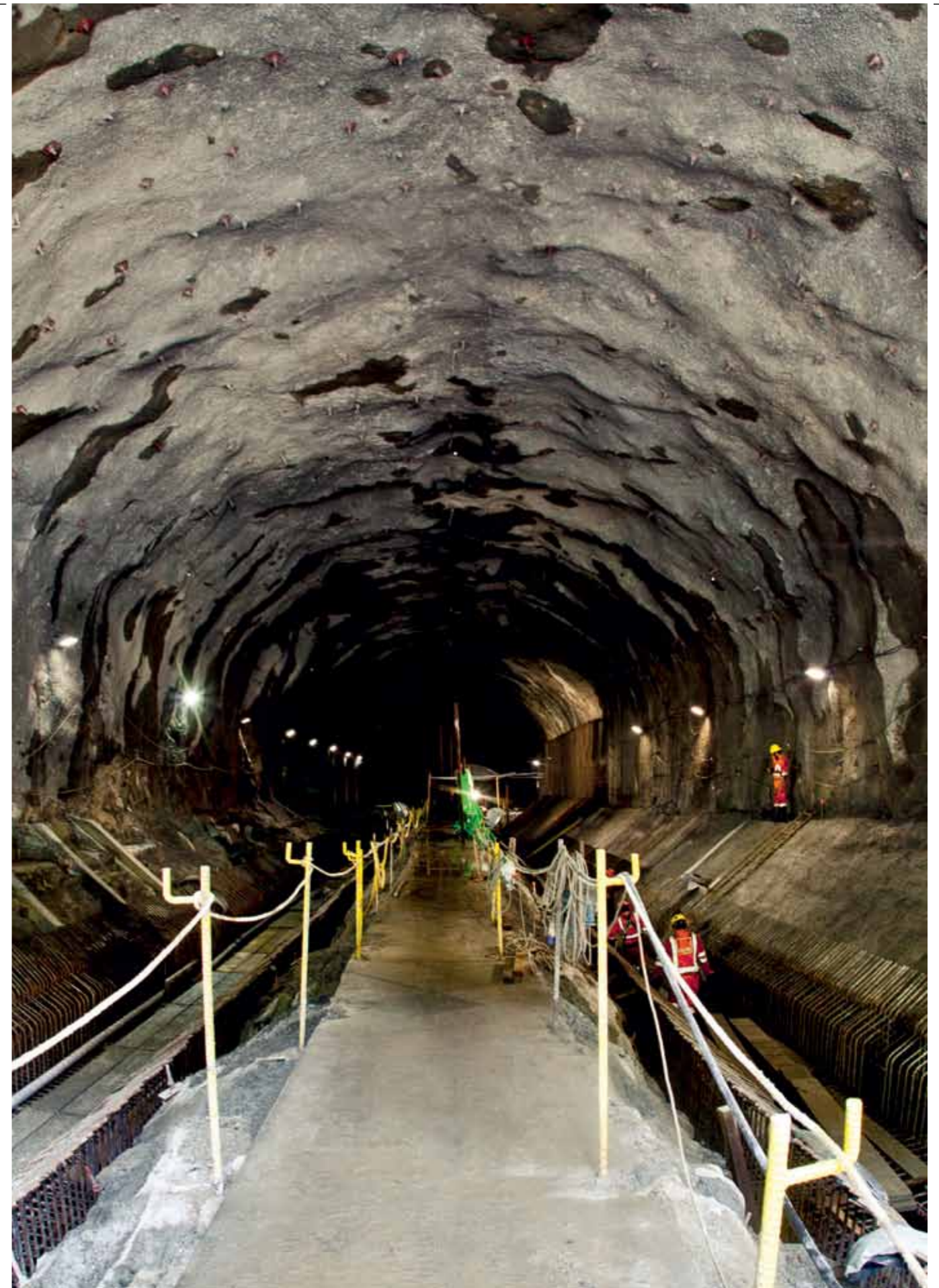
CENTRAL HIDROELÉCTRICA DE MACHU PICCHU
